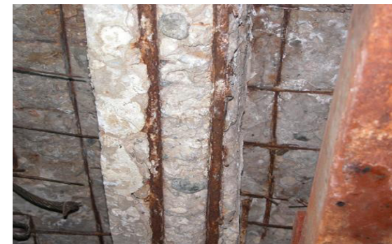
Рисунок 2 – Коррозия железобетона
