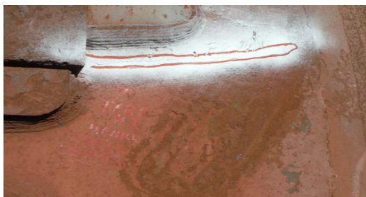
Рисунок 2 – Неразрушающий контроль корпуса печи, влажный визуальный магнитопорошковый контроль (WVMT)
